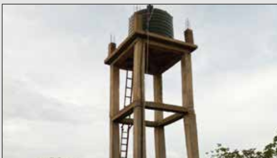
Construction d'un chateau d'eau (Diocèse de Sokodé)
