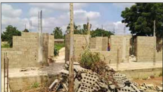
Chantier du presbytère de la paroisse Sainte Famille de DZREKPO-CENTRE (Diocèse d'Aného)
