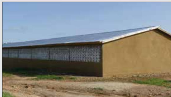
Construction d'un bâtiment de trois classes à Sokodé (Diocèse de Sokodé)
