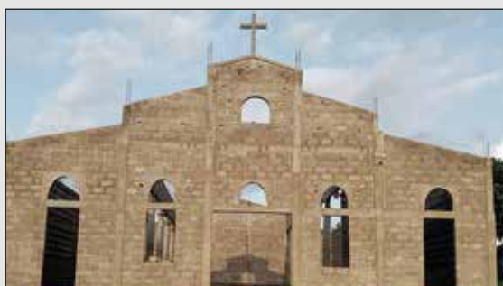
Chantier de l'église de Akpaka (Diocèse d'Atakpamé)
