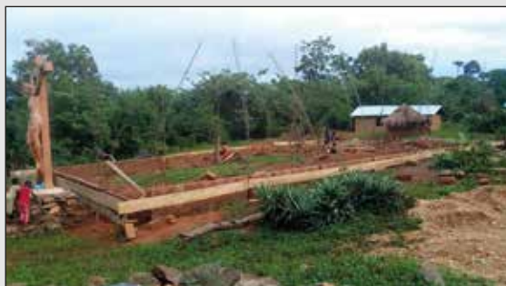
Implantation du chantier de la chapelle de Agadja à Ona (Diocèse d'Atakpamé)
