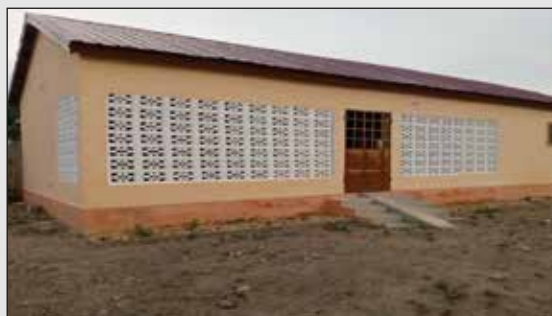
Construction d'un Presbytère à Kazaboua Paroisse St Jean Paul II (Diocèse de Sokodé)
