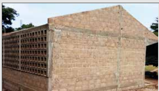
Chantier de l'école catholique de Ghin-Copé (Diocèse d'Atakpamé)
