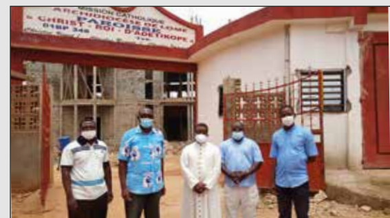
Visite de l'Archevêque sur le chantier d'Adéti- kopé entouré du Curé et ses vicaires (Archidiocèse de Lomé)
