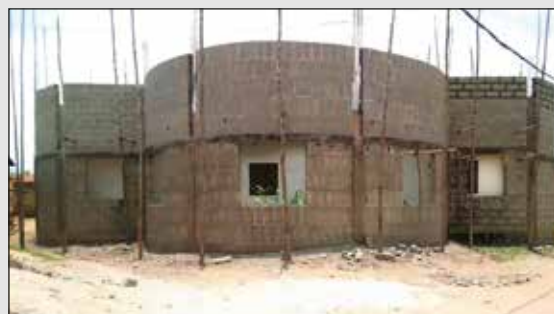
Construction de l'Eglise St Michel de Gadzegan (Diocèse de Kpalimé)
