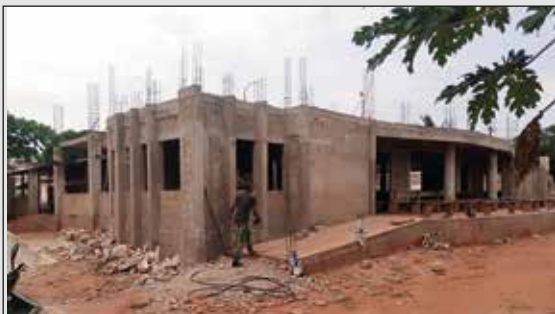
Chantier de l'Eglise Ste Famille d'Attiégo (Archidiocèse de Lomé)
