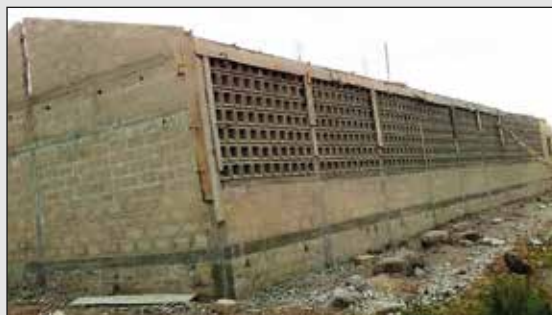
Chantier de l'école catholique de Yélumbé (Diocèse d'Atakpamé)
