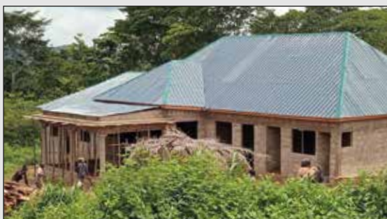
Construction du presbytère Paroisse St Benoît de Danyi (Diocèse de Kpalimé)
