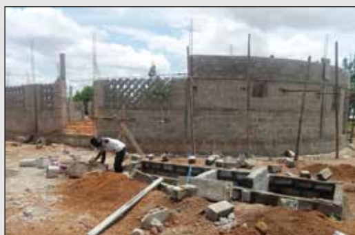
Chantier de la Paroisse N D de Lourdes de Nano (Diocèse de Dapaong)
